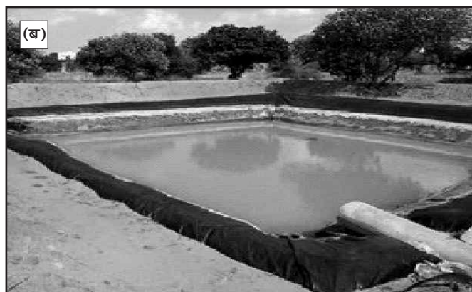
चित्र-2 : (अ) जल संग्रहण के लिए तालाब का निर्माण (ब) पॉलीथीन के उपयोग से तालाब का सुदृढीकरण।
